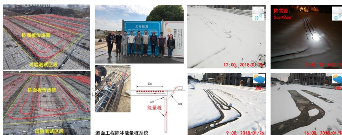
图 2 路面工程除冰融雪系统能量桩技术应用效果图
